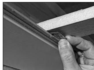
Befestigungskralle setzen
