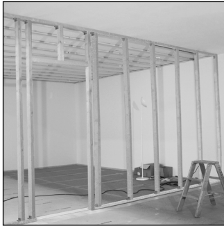
Unterkonstruktion
