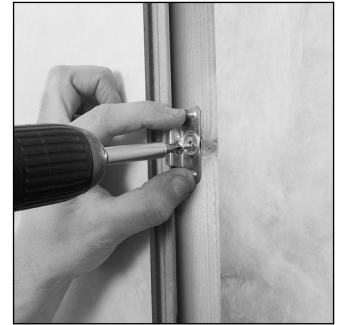
Mittelklammer setzen
