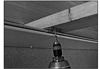
Befestigungskralle anschrauben
