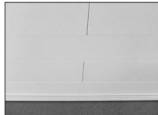
Deckenabschlussleisten aufstecken – fertig
