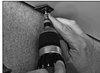
Leistclip montieren
