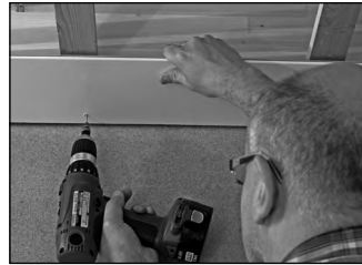
Erstes Steck-Paneel befestigen
