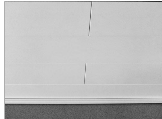
Deckenabschlussleisten aufstecken – fertig
