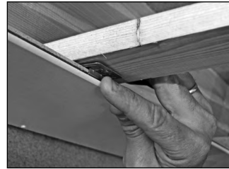
Befestigungskralle setzen
