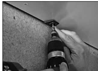
Leistclip montieren
