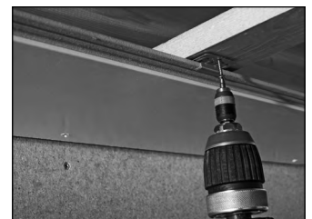
Befestigungskralle anschrauben
