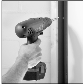
Befestigungsschiene setzen
